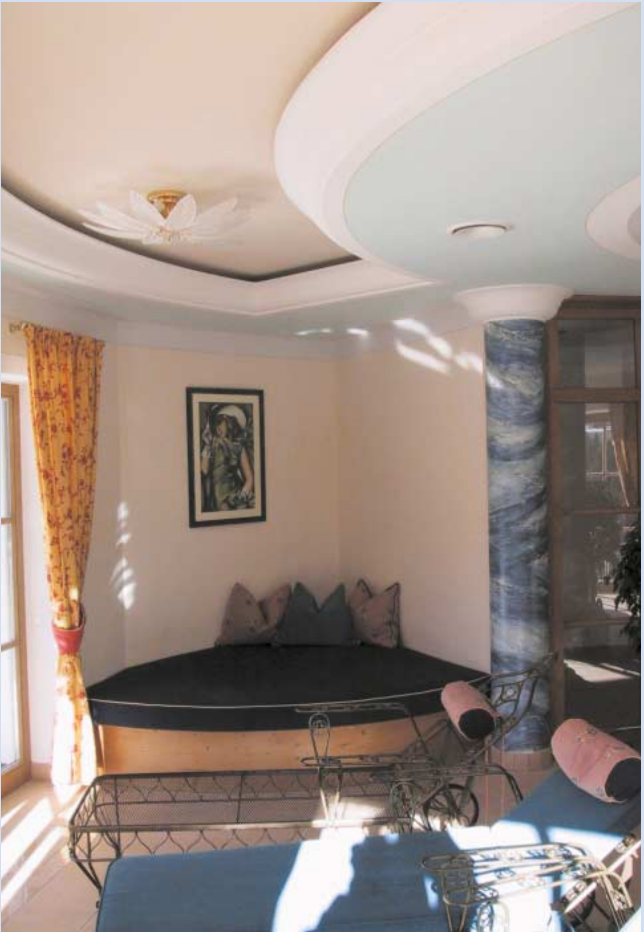
Stukkprofil mit indirekter Beleuchtung kombiniert mit Rundsäule/Kapitell Cornice in gesso con illuminazione indiretta allinata con colonna rotonda/capitello
